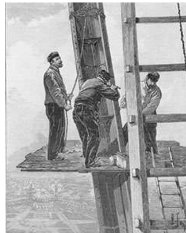
Figure 1 : Boulonnage du joint de deux arbalétriers
