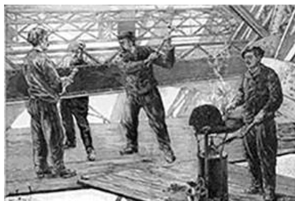
Figure 2 : Un poste de riveurs. Copyright : Collection Tour Eiffel
