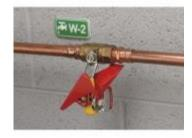
Il est conseillé de munir vos installations de dispositifs de séparations équipés de moyens de condamnations intégrés (vannes ou purges cadenassables...). Pour les équipements non équipés de ces moyens intégrés, des mesures compensatrices telles que des chaînes ou encore des équerres soudées doivent être mises en place.
