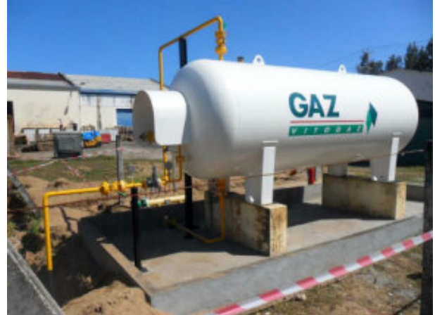
Installation d'une citerne de gaz
