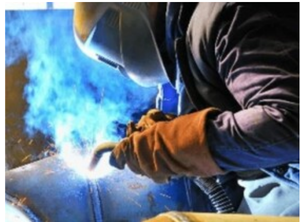
Opération de soudage sur tube
